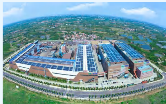
Fotovoltaik Atap Daerah Pabrik Taman Industri GEM Wuhan
