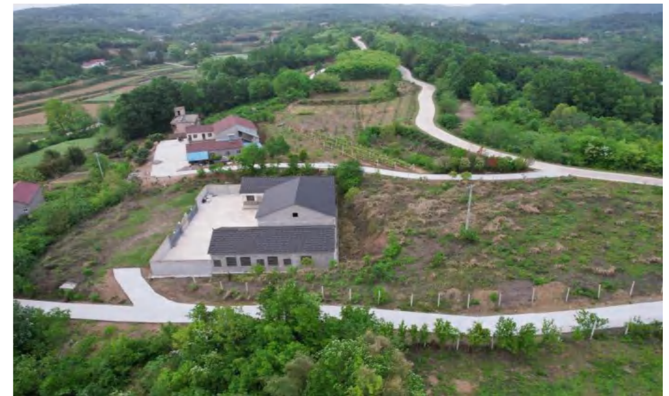
Membantu menyelesaikan pembangunan jalan di Desa Jinghe
