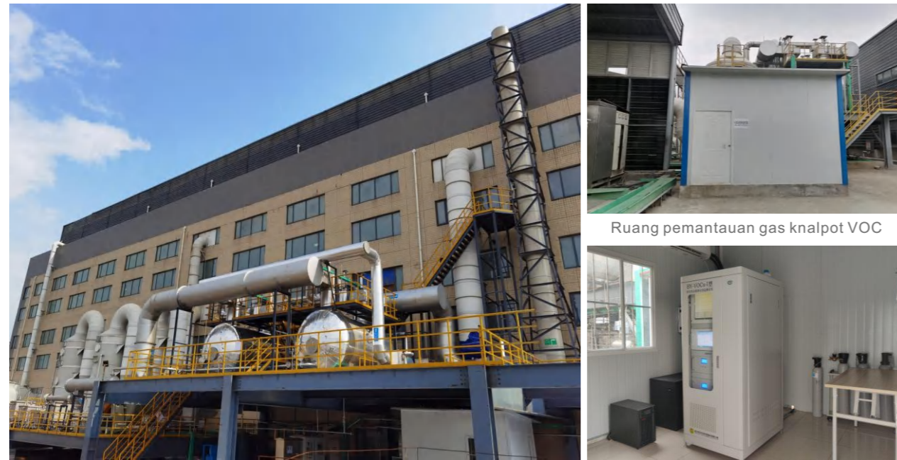
Perangkat analisis adsorpsi dan desorpsi VOC di kawasan industri Jingmen
