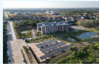
GEM武漢工業団地駐車場用屋上式太陽光発電カーポート
