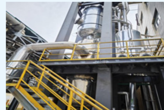
ストリップング・ヒートポンプ蒸留装置
